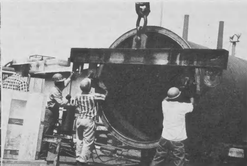
CHIMINEA DI Vacuum Still nobo tin un altura di como 180 pia ariba tera. E proyecto, cu a cuminsa na November, ta programá pa ser terminá na Juli. Bell Caribbean ta contratista pa mayoria di e trabao di construcion.
